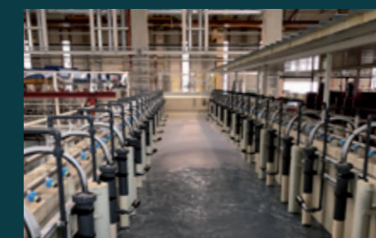
KTL & Vorbehandlung 12 Tauchvorgänge zur chemischen Reinigung und anschließende KTL-Beschichtung
