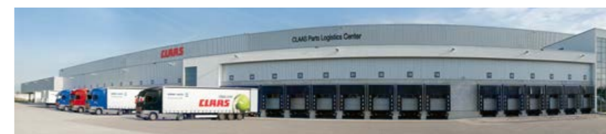
Das CLAAS Parts Logistics Center in Hamm, Deutschland, verfügt über 155.000 verschiedene Teile auf mehr als 100.000 m² Betriebsfläche.
