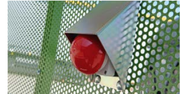
Die optionale akustische Füllstandsanzeige wird von einem Füllstandssensor an der Rückwand angesteuert.
