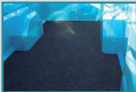
Revêtement du fond en résine
