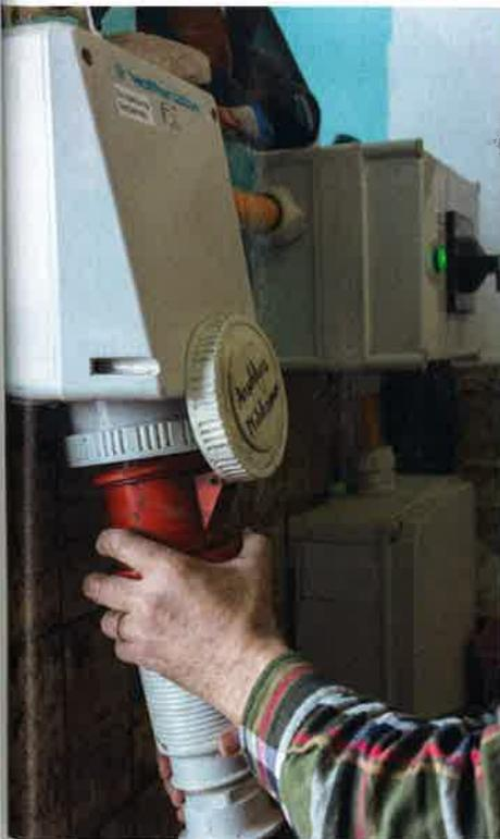
Das Generatorkabel wird am Netzumschalter eingesteckt.
