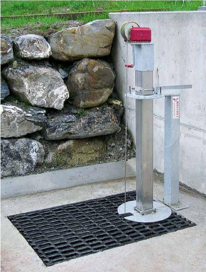
Dispositif d'abaissement et de pivotement
