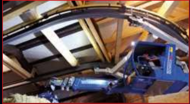
Kurvenfahrwerke sind optimale Lösungen für querliegende Gebäude (hydr. Vorsteuerung mit H/S-Ventil).
