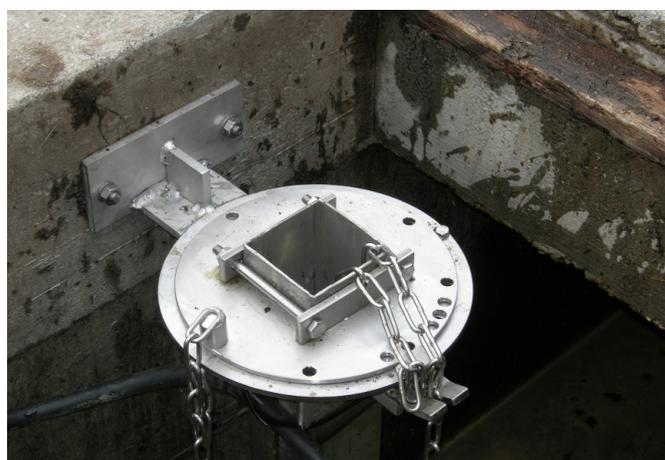
Dispositif de pivotement et d'abaissement –
